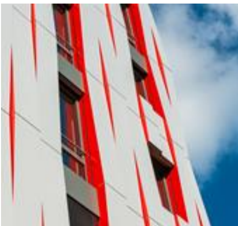
Eröffnung des HOLM-Gebäudes am 3. Juni 2014
